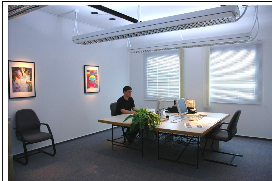
Abb. 2: Versuchsraum, mit Direkt- Indirektbeleuchtung, Tageslicht und Akzentuierung
