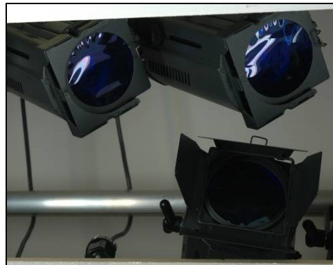
Abb. 7: Strahler mit Filtervorsatz
